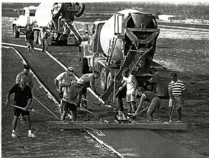
Hình 5-21: Trộn và đổ bê tông.
