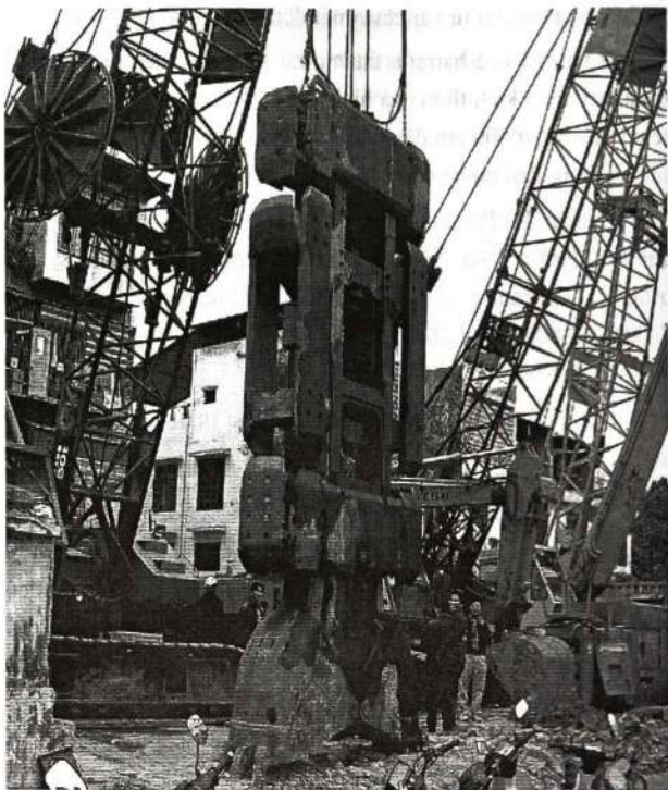
Hình 6-15: Thiết bị đào kiểu gầu ngoạm
