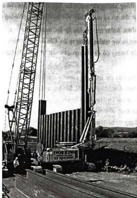
Hình 3-10: Thi công ép cọc cừ.
