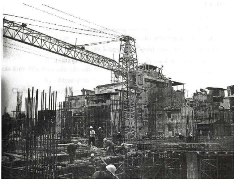
Hình 9-13: Cần trục leo dặt trong công trình.
