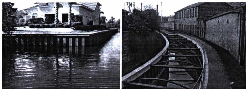
Hình 1.9. Cừ thép sử dụng trong kè bờ và kênh mương
