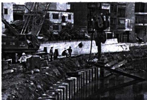
Hình 1.18. Đóng cừ kè bờ kênh Nhiều Lọc, TP Hồ Chí Minh
