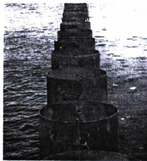
Hình 1.6. Cừ thép với cọc ống thép
