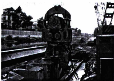
Hình 1.14. Thi công đóng cừ BTCT bằng
