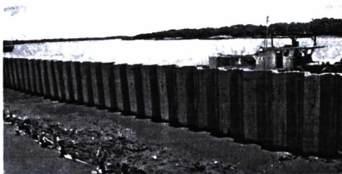
Hình 1.16. Công trình kè nhà máy nhiệt điện Nhơn Trạch 1, tỉnh Đồng Nai ứng dụng công nghệ cừ BTCT dự ứng lực
