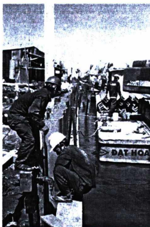
Bắt vít cừ và dầm ốp bằng gỗ
