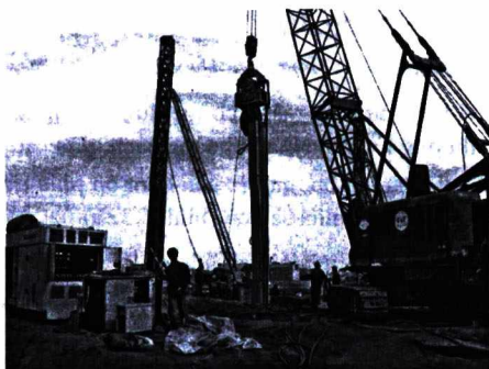
Hình 5.30. Phương pháp đóng cừ đơn
